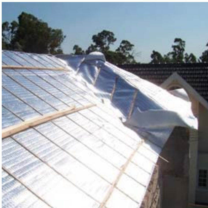
De arriba a abajo; Colocación de tejas francesas y forma de extensión de la Membrana ISOLANT con la doble alfaja y clavaderas
